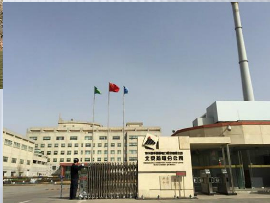
Пекінська вугільна електростанція Guohua, Пекін.
