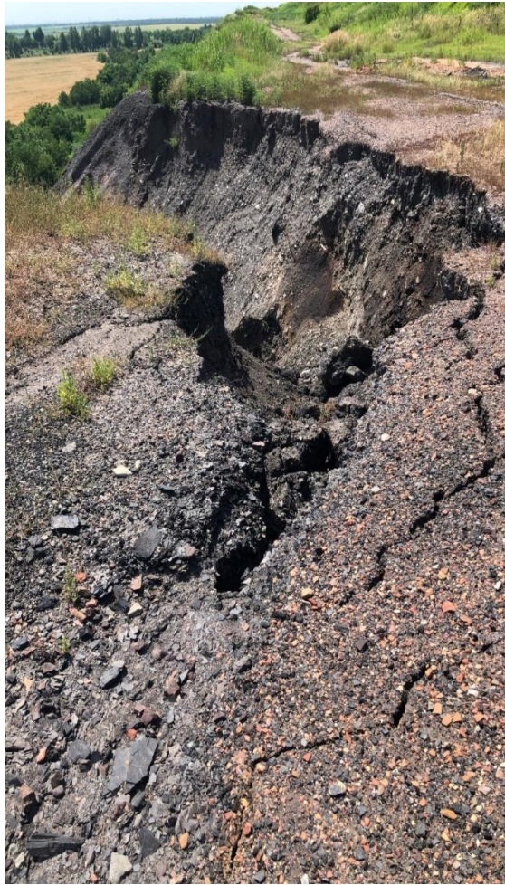
Рис. 7, 8. Процеси руйнування терикону шахти Родинська (рік після закриття)
